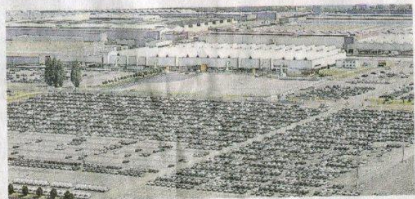
La plus grosse opération (3,2 millions) permettra de récupérer des terrains de l'usine PSA La Janais, situés à Chartres-de-Bretagne, près de Rennes.
