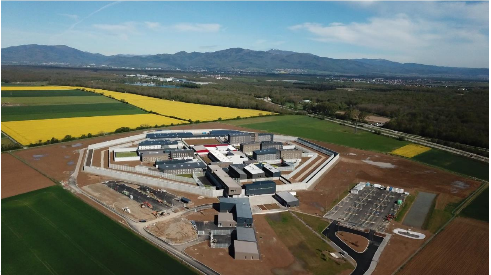
Centre Pénitentiaire de Lutterbach
